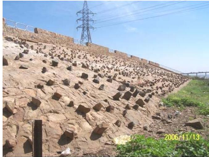
图 3 苏丹青尼罗河加糙的硬化河岸
